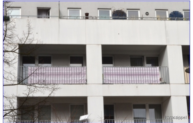
Blick von außen
