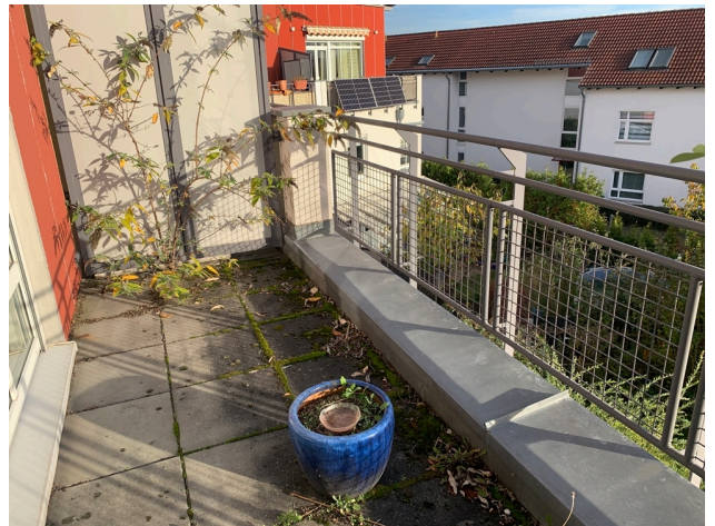
2- OG - die Dachterrasse
