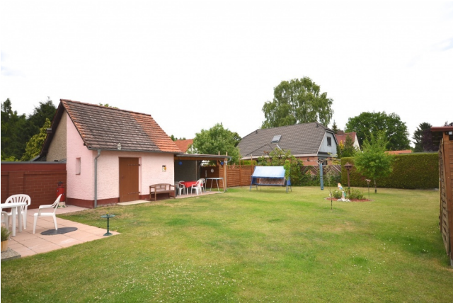
das massive Nebengebäude
